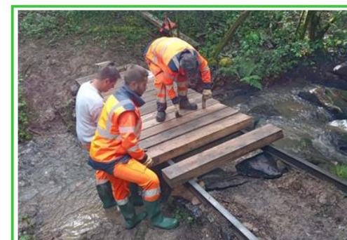
Fabrication de la passerelle sur le ruisseau Fromager
